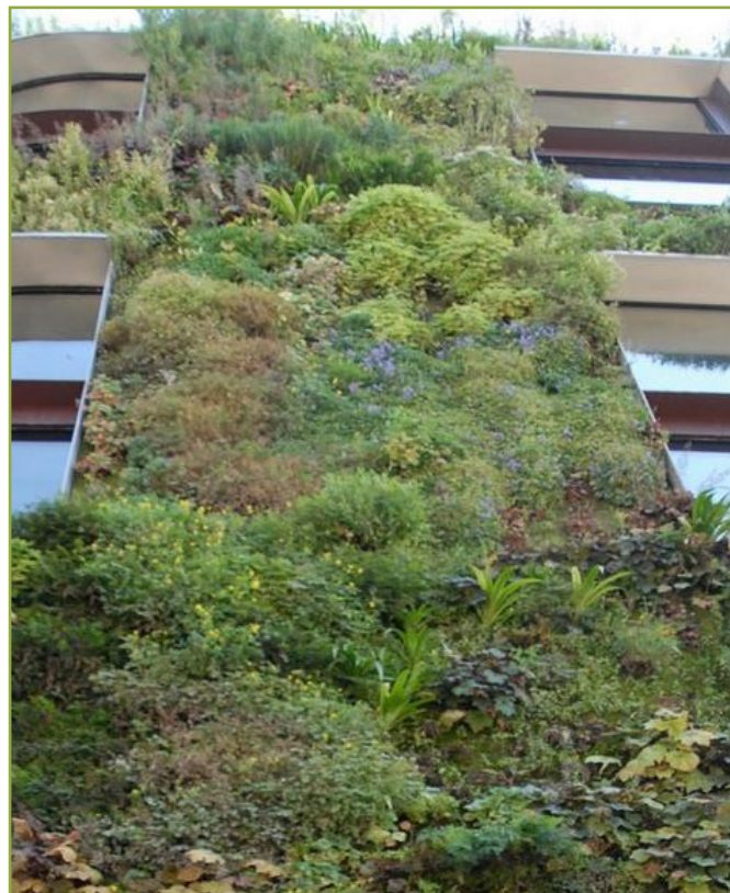
Figure 11 : photo de mur végétal sur nappe continue. Source : C. Guinaudeau – musée du quai Branly.
