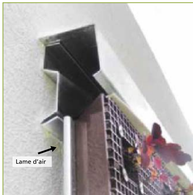
Figure 15 : photo montrant la lame d'air ménagée derrière un mur végétalisé.
