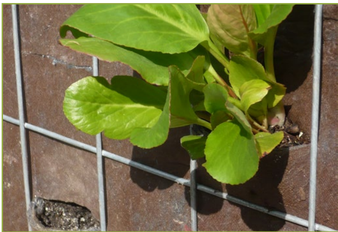
Figure 18 : photo d'une plantation par incision de la toile de protection extérieure. Source : T. Muller.
